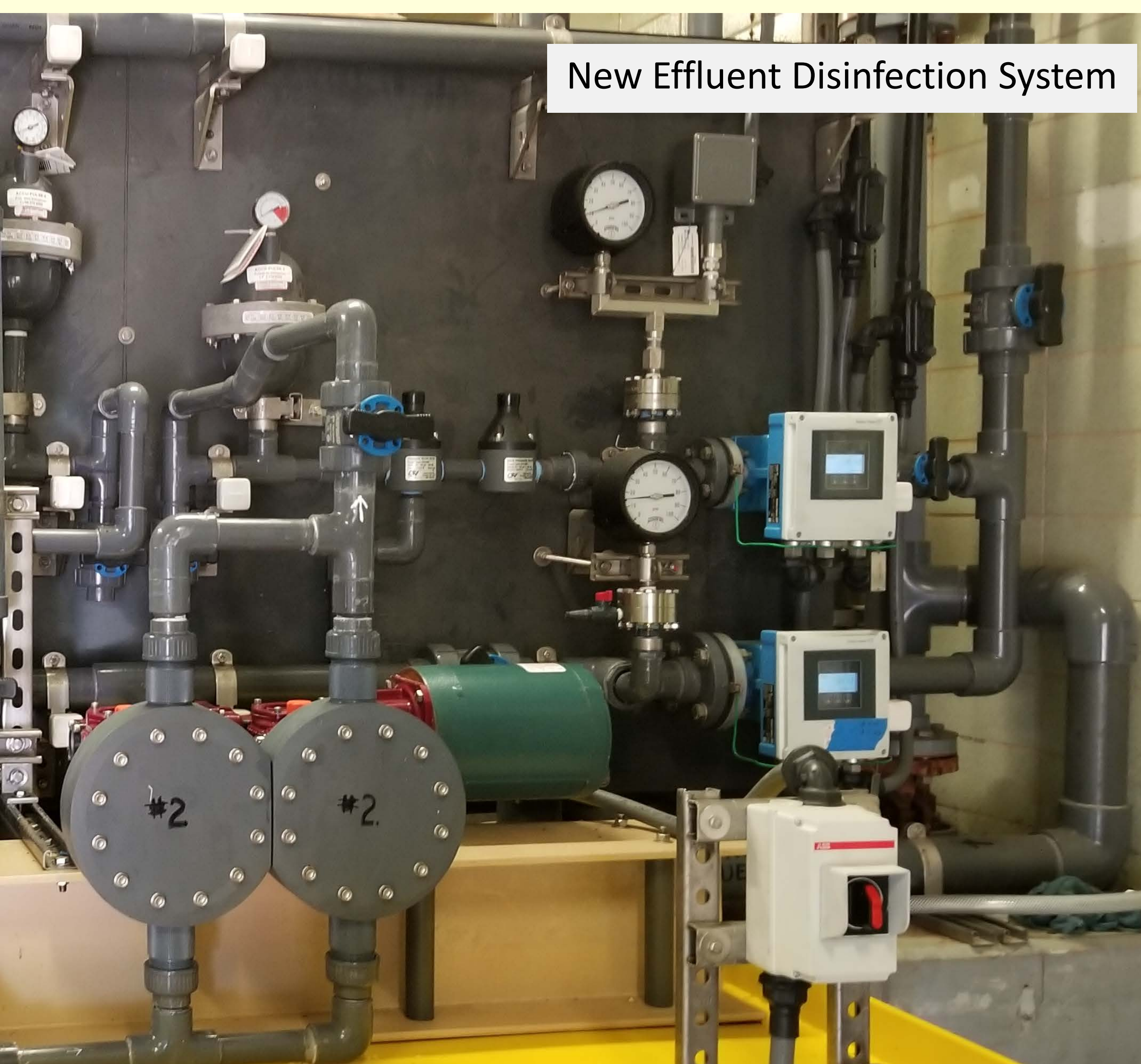
Effluent Reuse Process Piping
